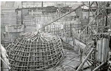
Bild Nr. 151: Los III: Blick in die Krafthausbaugrube. Betonierung des Einlaufkegels für landseitige Turbine, Vorbereitung der Schalung für die Einlaufspirale vom 09. Jan 1931
