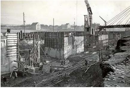
Bild Nr. 38: Los I: Schleusenammermauer im Bau, Mauerung des Schleusenumlaufs für flussseitiges Schleusenunterhaupt vom 21. Nov 1929
