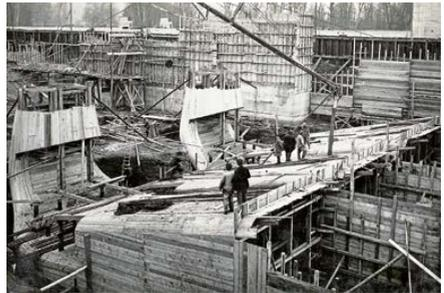
Bild Nr. 138: Los III: Blick auf die Saugschlauchschalung vom 19. Nov 1930
