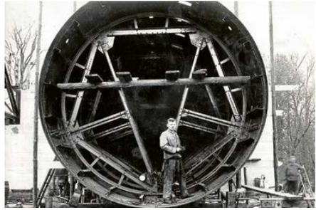
Bild Nr. 70: Los V: Innenansicht und Konstruktionseinzelheit des Zylinderquerschnitts für Walze in Wehrröpfung „L“ vom 24. Apr 1930
