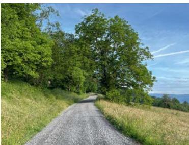
Im Rahmen der Straßenunterhaltsmaßnahmen wurde der Weg Richtung Galgen überarbeitet. Das Teilstück bis zum Wanderparkplatz wurde neu asphaltiert und im weiteren Verlauf komplett überarbeitet, sowie mit einer Schottererschicht versehen. Der alte Weg mit den betonierten Wegeplatten war in die Jahre gekommen und durch die Plattenverschiebungen bestand allerhöchste Unfallgefahr. Die Betonoberfläche wurde vor Ort zerkleinert und wieder
