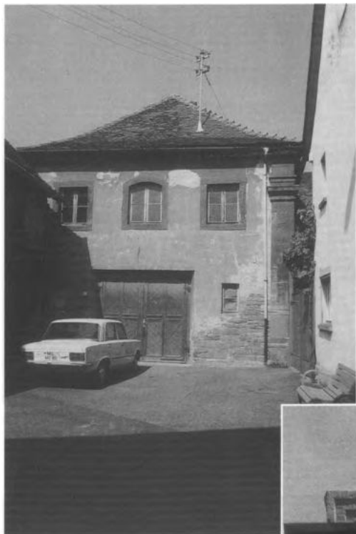
Vor der Renovierung um 1975
