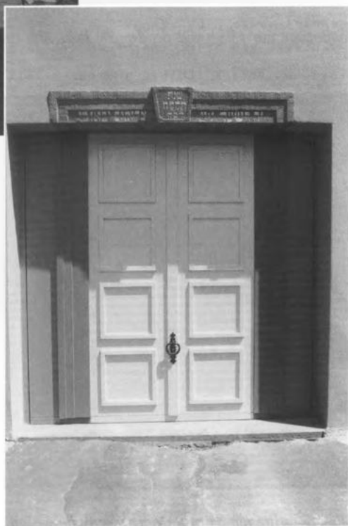
Eingangstüre mit Türsturz nach der Renovierung
