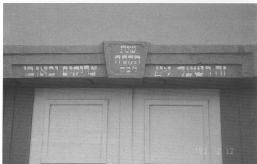
Eingangstüre mit Türsturz nach der Renovierung
