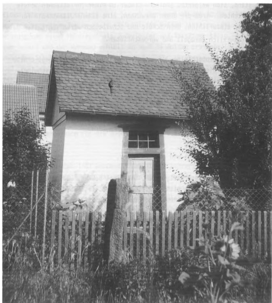
Das Judenbad (Mikwe) nach der Renovierung.
