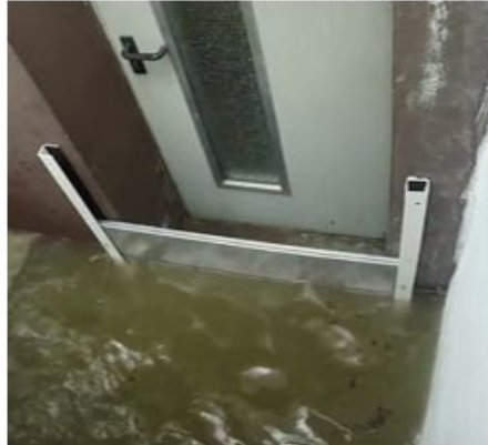
Dammbalkensystem: Alu, Siebdruckplatten (mobil und fest installiert)
